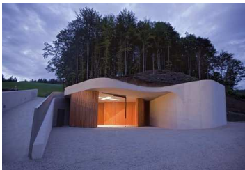
OFIS arhitekti, Farewell Chapel, 2005-2009 Krasnja, Slowenien Foto: Tomaz Gregoric Courtesy OFIS arhitekti
